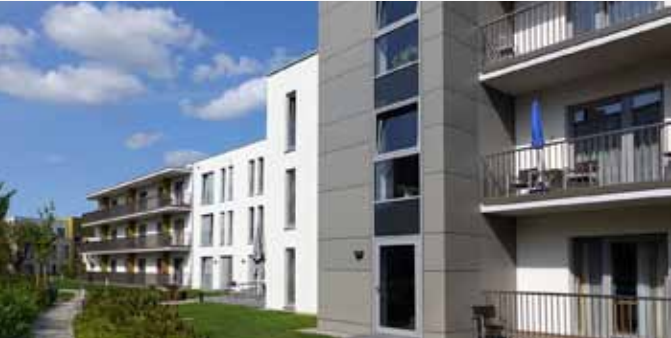
Quelle: fmr Architekten Greifswald
