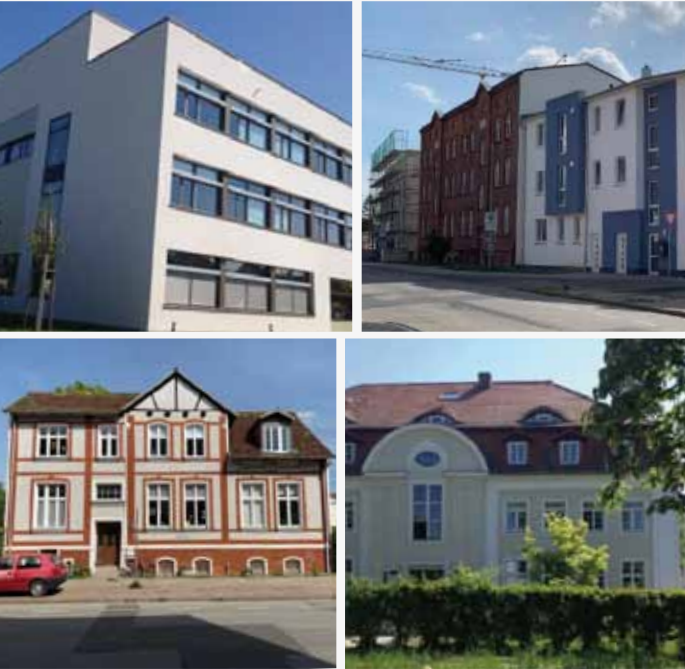
Nachbarbebauung Loitzer Straße - Soldmannstraße
